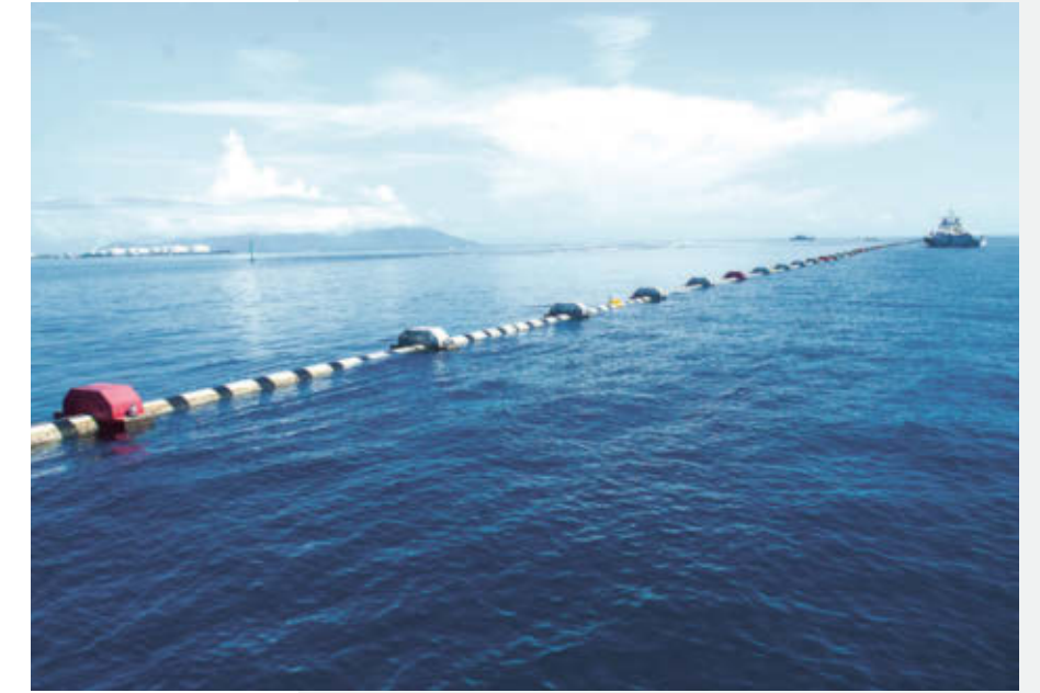
↑ Yaklaşık dört kilometre uzunluğundaki bir boru, Tahiti'nin başkentindeki hastaneyi deniz suyuyla soğutuyor.
