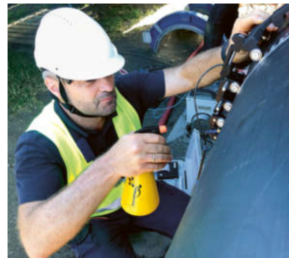
↑ Tahiti'deki denetmenler, bunun için hazırlanması gereken borulardaki kaynak dikişlerini kontrol etmek için tarayıcılar kullandı.
