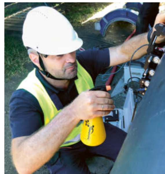
↑ Inspectorii din Tahiti au verificat cu scanare îmbinările sudate ale conductelor, care trebuiau pregătite în acest scop.
