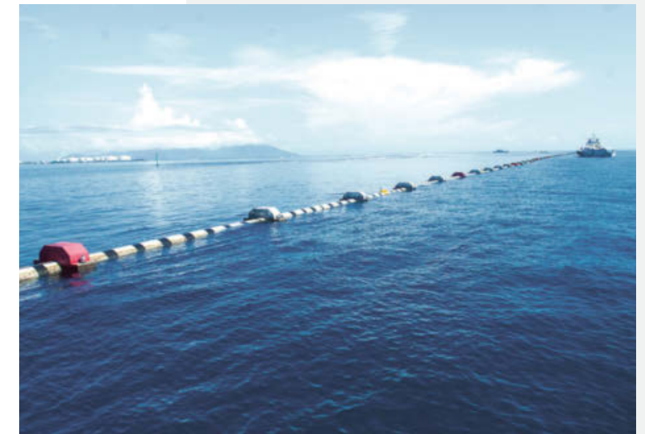
↑ O conductă cu o lungime de aproape patru kilometri asigură răcirea cu apă de mare în spitalul din capitala tahitiană.
