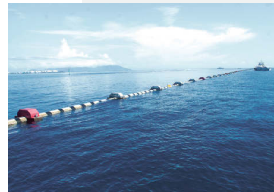
↑ Un tubo lungo quasi quattro chilometri rinfresca l'ospedale della capitale di Tahiti con acqua di mare.
