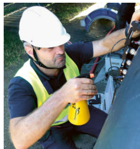
↑ A Tahiti, gli ispettori hanno utilizzato scanner per verificare le saldature dei tubi che sono stati appositamente preparati.
