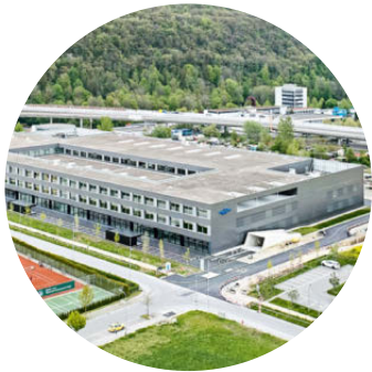
Der neue Hauptsitz Biel mit 17'000 Quadratmetern Produktions-, Montage- und Bürofläche.
