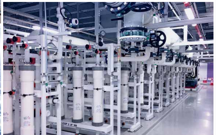
SYGEF Plus all'opera: il sistema di tubazioni, valvole e strumenti di misurazione trasporta in modo sicuro liquidi di processo altamente sensibili attraverso le camere bianche di produzione di Micron. Ne vanno fieri (foto in alto a destra, da sinistra) Elin Teo, Jo Lim e Ramesh Dhanabalan, Global Facilities, Construction & Engineering, Senior Manager presso Micron.
