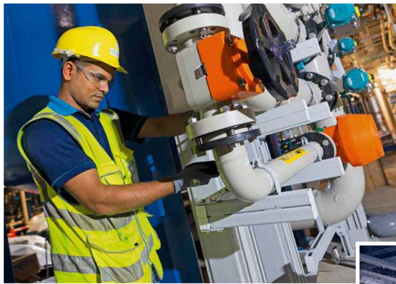
SYGEF Plus en service : le système de tuyaux, robinets et instruments de mesures transporte en toute sécurité des liquides de process hautement sensibles dans les salles blanches de Micron. Sont ici présents Elin Teo, Jo Lim et Ramesh Dhanabalan, Global Facilities, Construction & Engineering, Senior Manager chez Micron (de g. à d.), que l'on voit sur la photo en haut à droite, en sont tous fiers.
