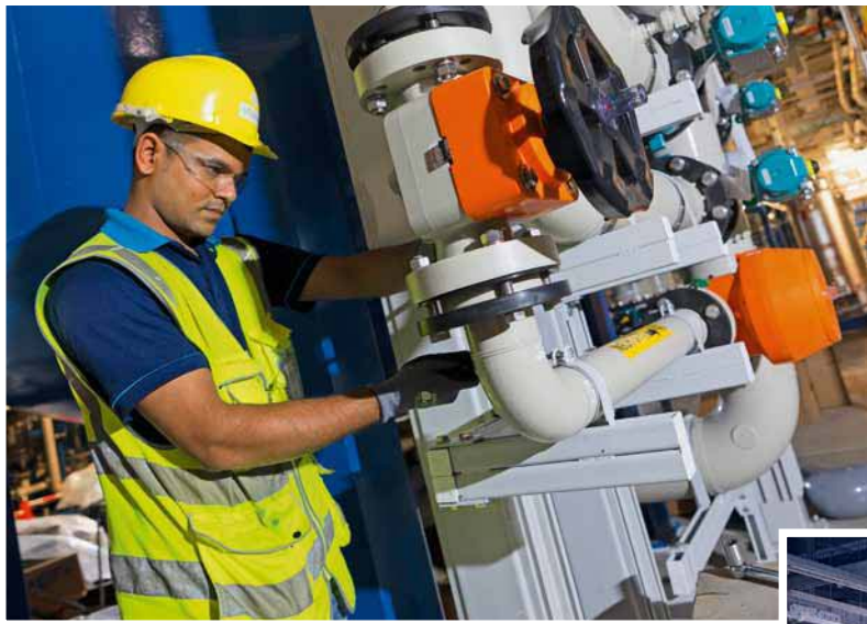
SYGEF Plus im Einsatz: Das System aus Rohrleitungen, Ventilen und Messinstrumenten transportiert hochsensible Prozessflüssigkeiten sicher durch die Reinraumanlagen von Micron. Darauf sind (Bild o.r.; v.l.) Elin Teo, Jo Lim und Ramesh Dhanabalan, Global Facilities, Construction & Engineering, Senior Manager bei Micron, stolz.
