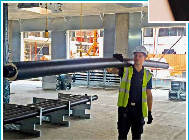
COOL-FIT 2.0 - 来自 GF Piping Systems 的轻质、预绝缘及防腐蚀解决方案。
