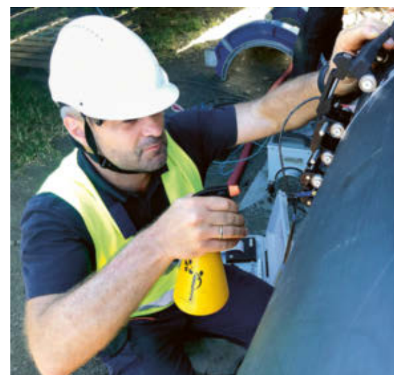
↑ Mit Scannern prüften Inspektoren in Tahiti die Schweissnähte der Rohre, die dafür vorbereitet werden mussten.
