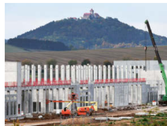
↑ In Sichtweite der Veste Wachsenburg bei Arnstadt in Thüringen (Deutschland) baute der Batterieproduzent CATL eine Fabrik.
