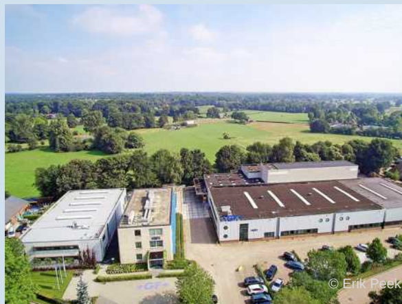
Uno sguardo dall'alto del grande complesso GF di 11.000 metri quadrati a Epe.
