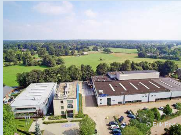
Ein Blick von oben auf das 11'000 Quadratmeter grosse GF Areal in Epe.
